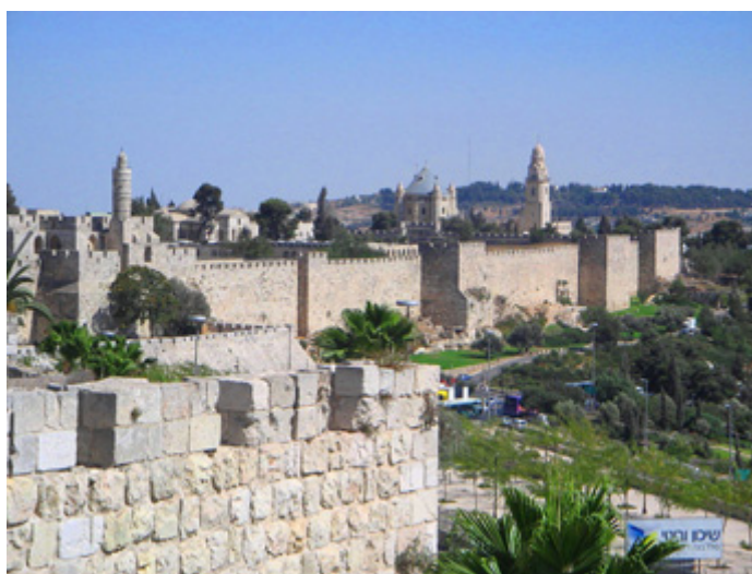
Photo 3 : les remparts restaurés
