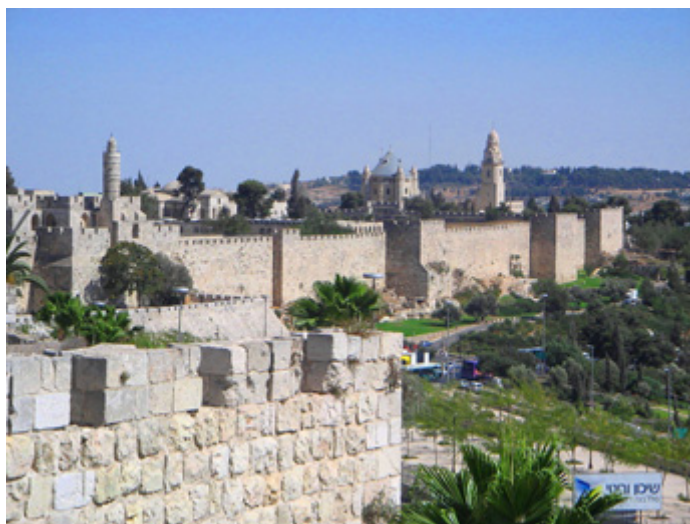
Photo 3 : les remparts restaurés
